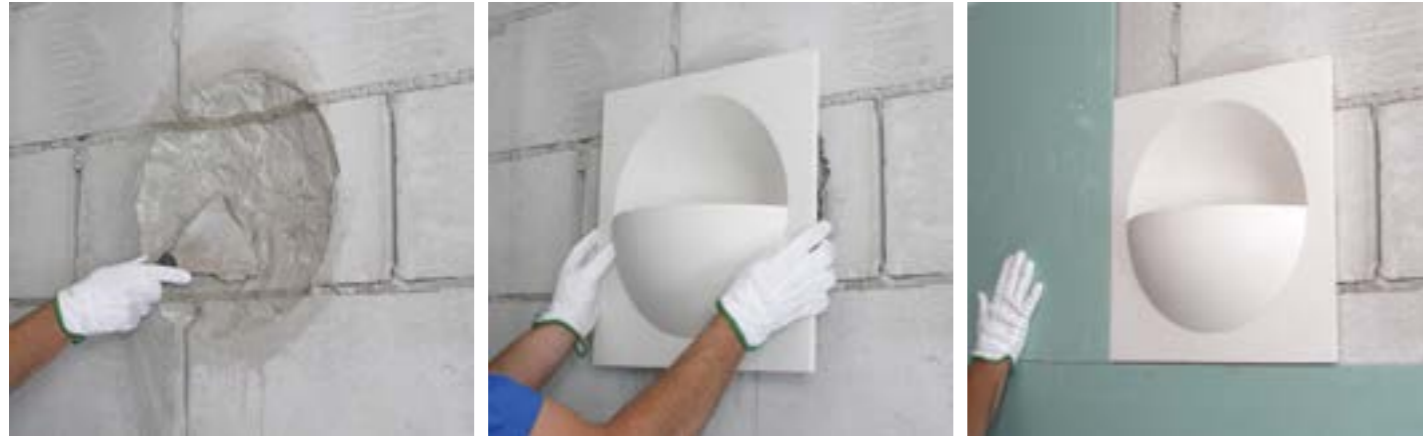
Pierwsza metoda montowania / The first method of mounting
